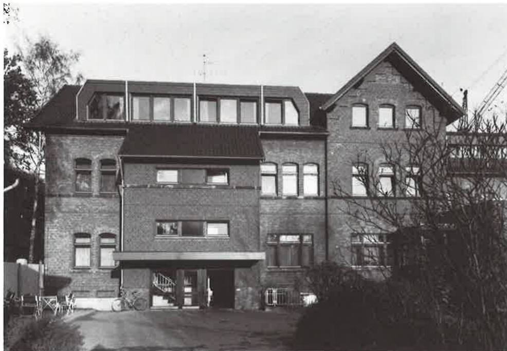
Haus 1 Teilansicht nach der Sanierung
