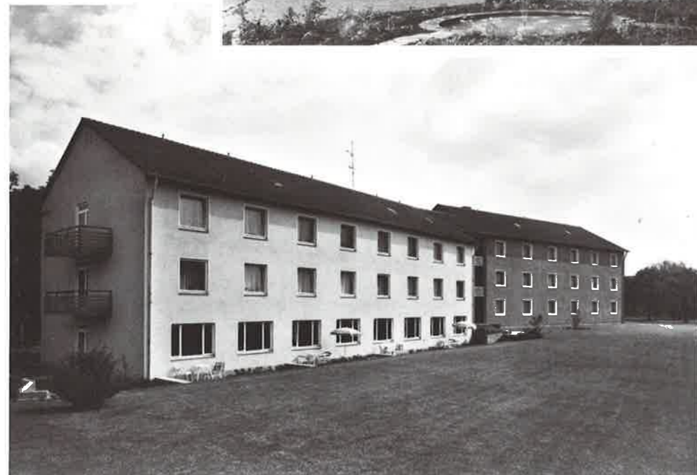
Schwester- und Schülerinnenwohnheim mit Krankenpflegeschule, Röntgenabteilung und Labor, jetzt Haus 9 und Haus 10.
